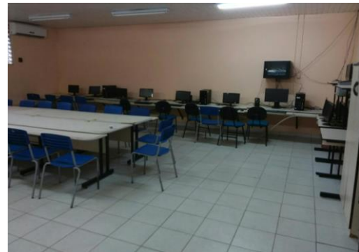
Lâmpadas queimadas e iluminação insuficiente
