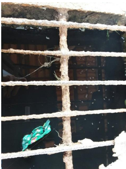
Caneleta de drenagem da Escola Terezinha Souza
