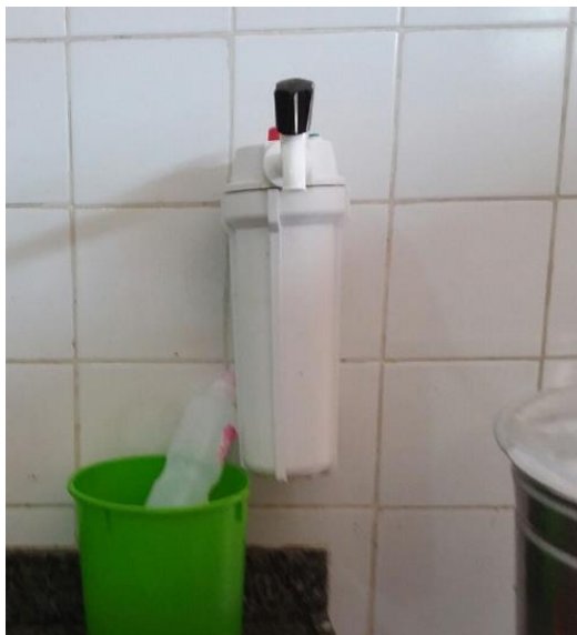
Escola Maria Madalena Raad - Substituição do filtro de água
