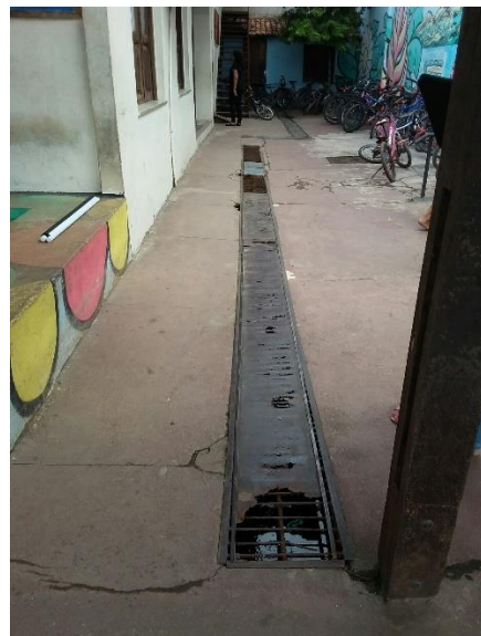
Caneleta de drenagem da Escola Terezinha Souza
