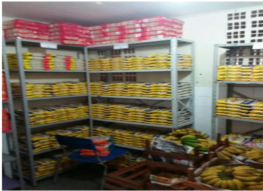
Ventilação insuficiente e tela de proteção inexistente
