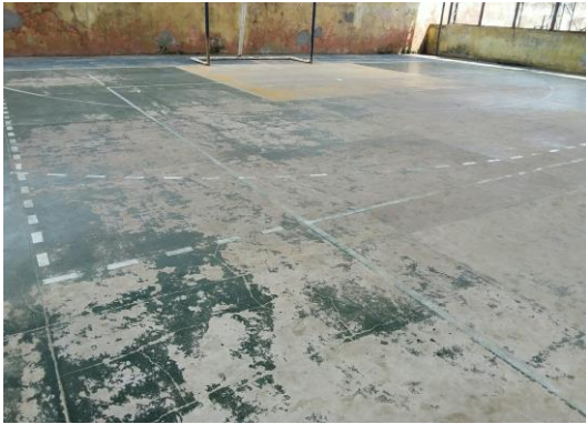
Pintura/marcação de linhas desgastadas
