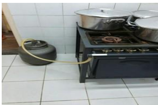
Botijão de gás no ambiente interno
