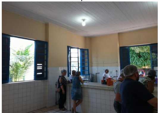
Inexistência de tela de proteção nas aberturas externas
