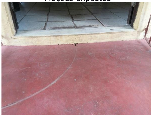
Limitação de acesso para PcD
