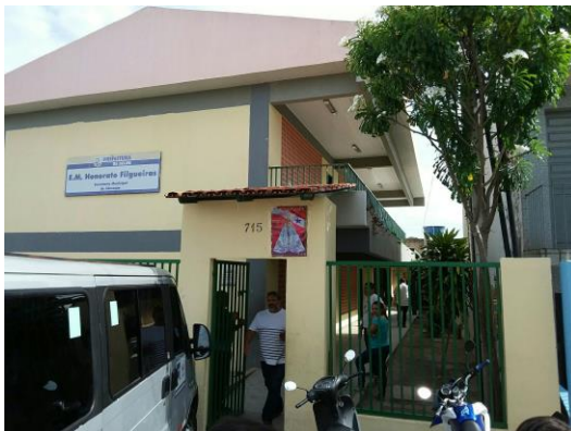
Muro baixo, sem concertina e cerca elétrica
