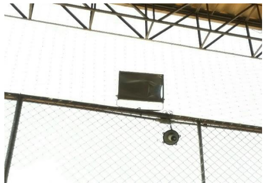
Iluminação inadequada e insuficiente
