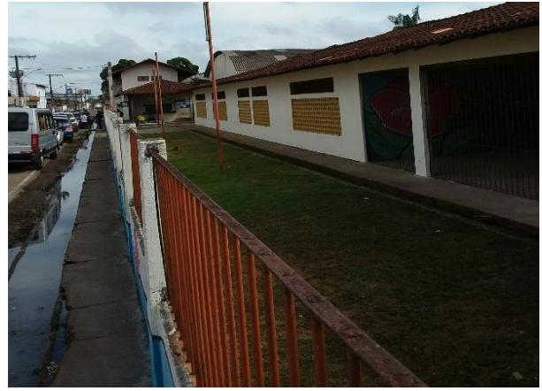
Muro baixo, sem concertina e cerca elétrica
