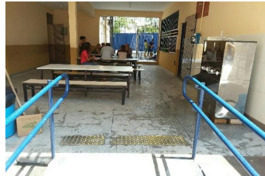
Espaço reduzido e mobiliário danificado
