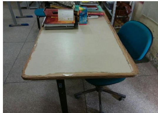
Mobiliário danificado e infiltração
