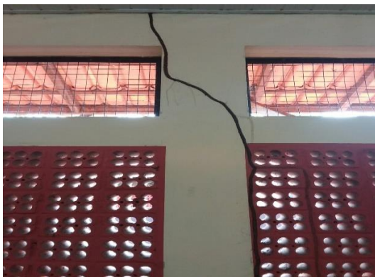
Presença de cupim e paredes das salas dificultam a acústica
