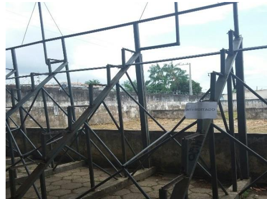
Arquibancada em obras
