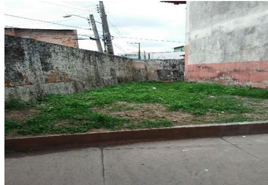
Muro lateral baixo, sem concertina e cerca elétrica
