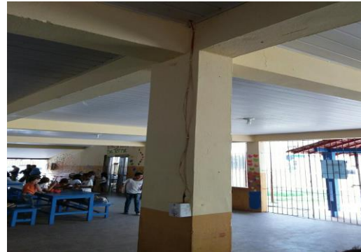
Fiações expostas e improvisadas
