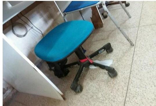
Mobiliário danificado e fiação exposta
