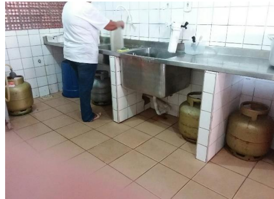
Espaço reduzido e botijão de gás em local inadequado
