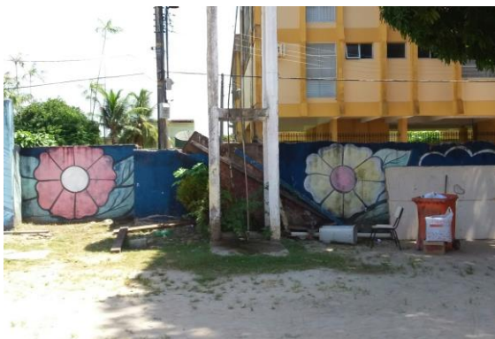
Cerca elétrica e concertina inexistência
