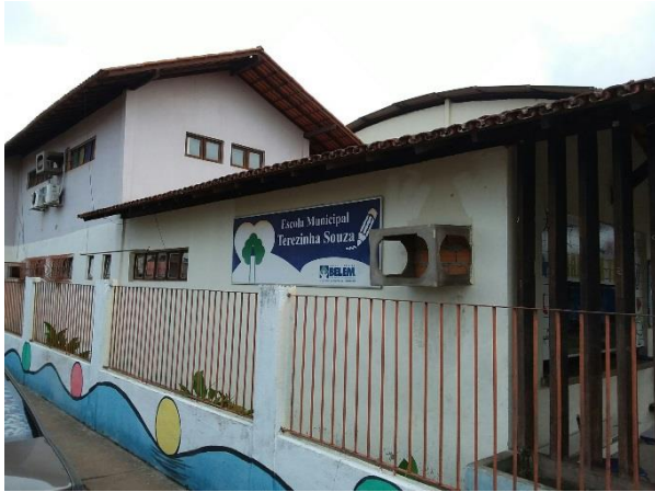
Muro baixo, sem concertina e cerca elétrica
