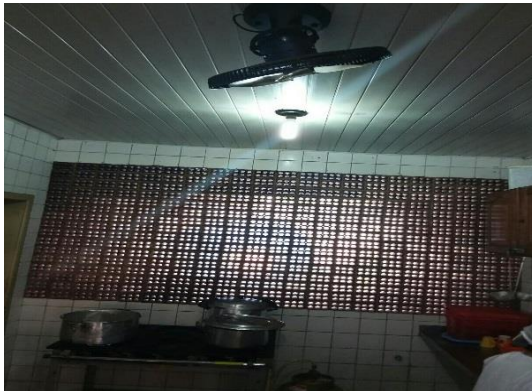
Iluminação e ventilação insuficiente e presença de ventilador na cozinha
