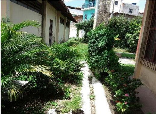
Necessidade de poda de árvore
