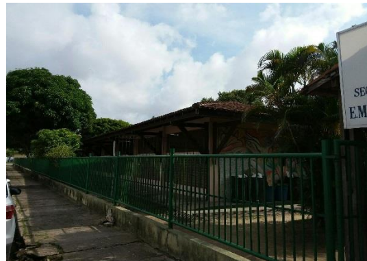
Cerca elétrica inexistente
