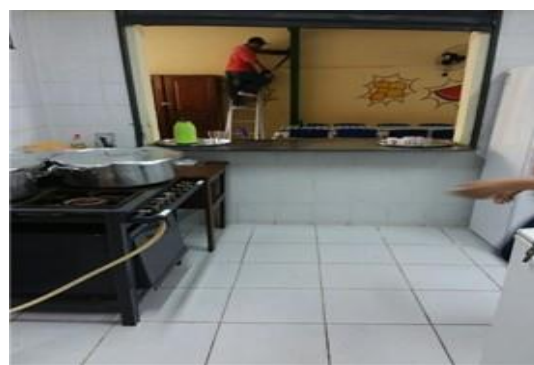
Inexistência de exaustor e tela de proteção
