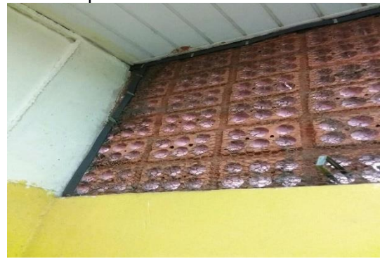
Tela de proteção nas aberturas externas e comunicação direta com a cozinha
