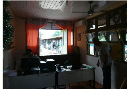
Iluminação insuficiente e lâmpada queimada
