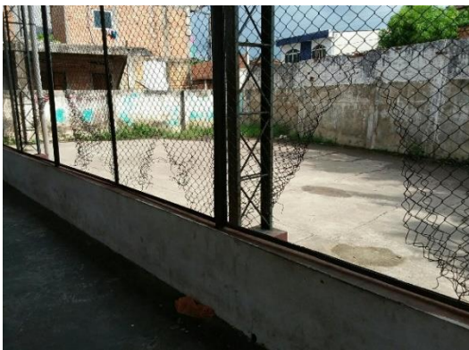
Tela de proteção danificada
