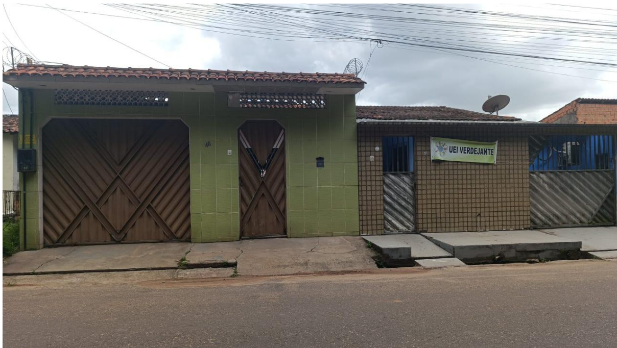
Imagem 01 - Fachada do imóvel
