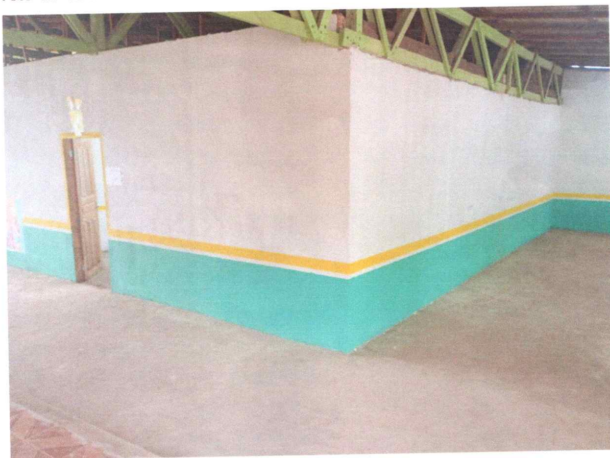
Foto 02- Vista do Interior do Imóvel
