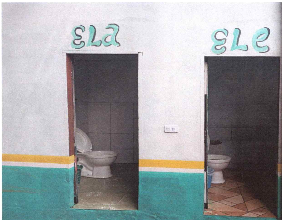
Foto 05- Entrada dos Banheiros
