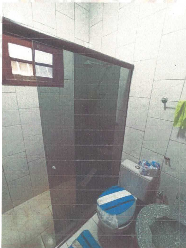
Imagem 09: Banheiro da suíte
