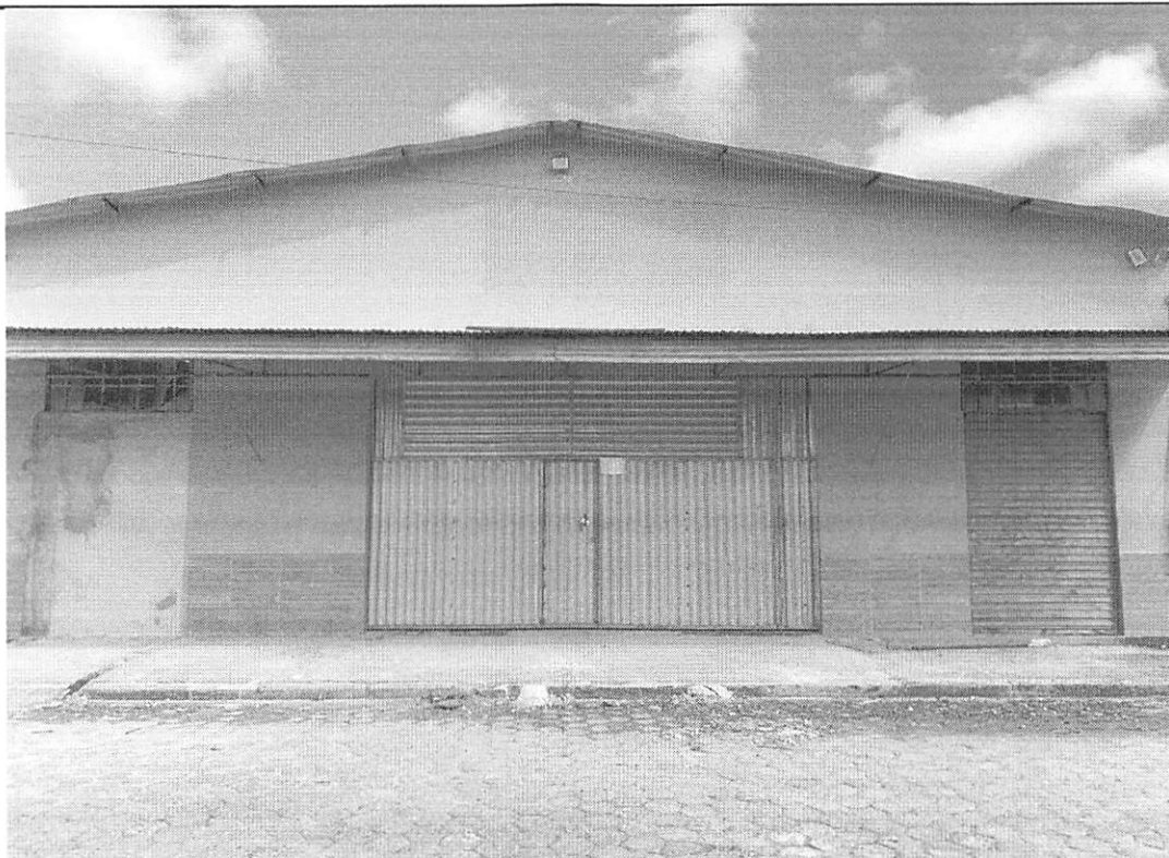
Fachada com acesso a área de entrada.
