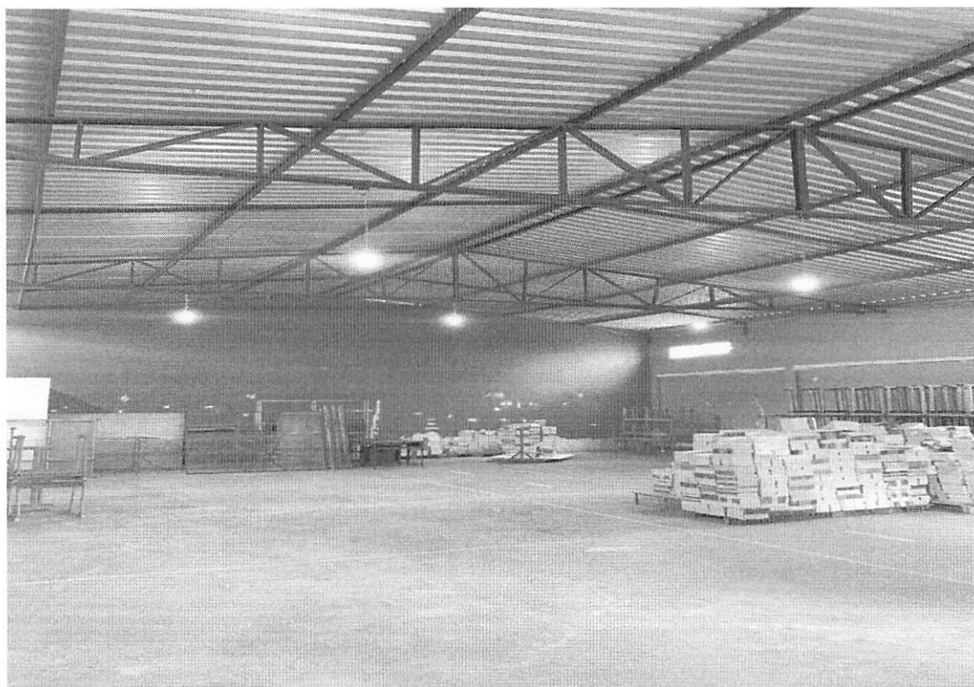
Área Interna do Galpão.
