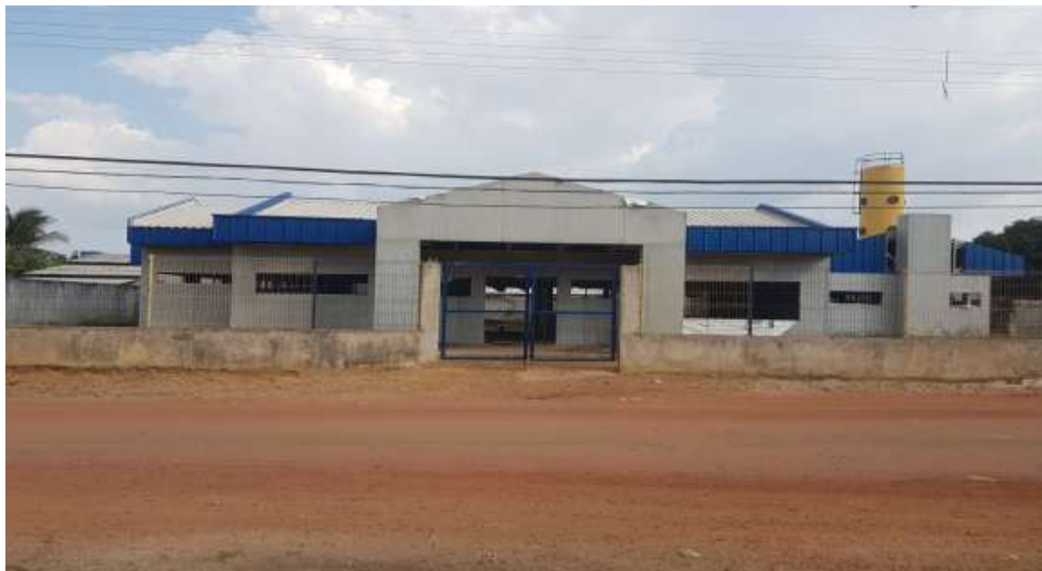
Figura 2 – Creche Novo Horizonte
