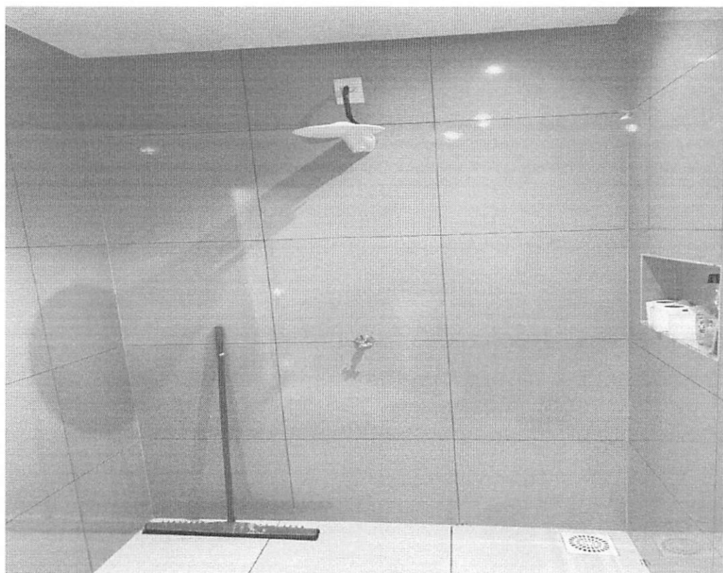
Interior do banheiro.
