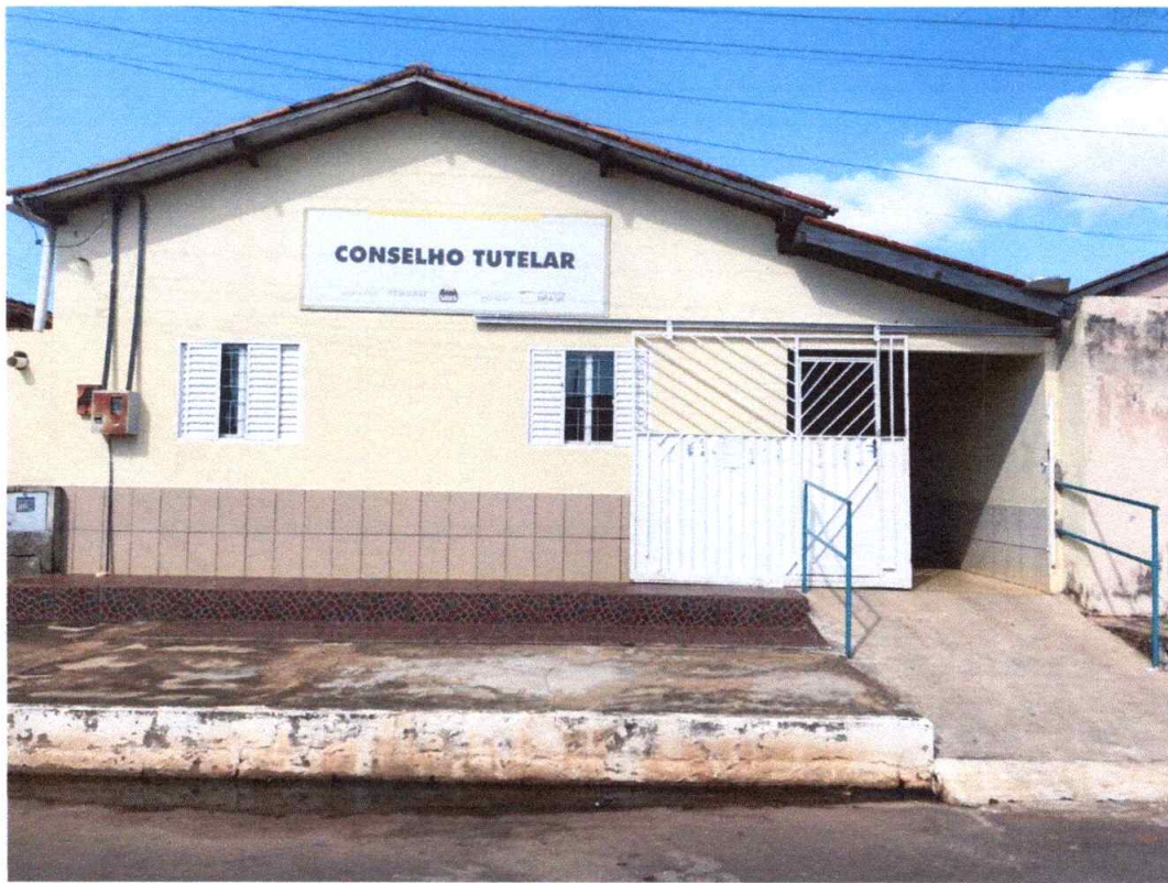
Figura 2 – Imagem frontal do imóvel.
