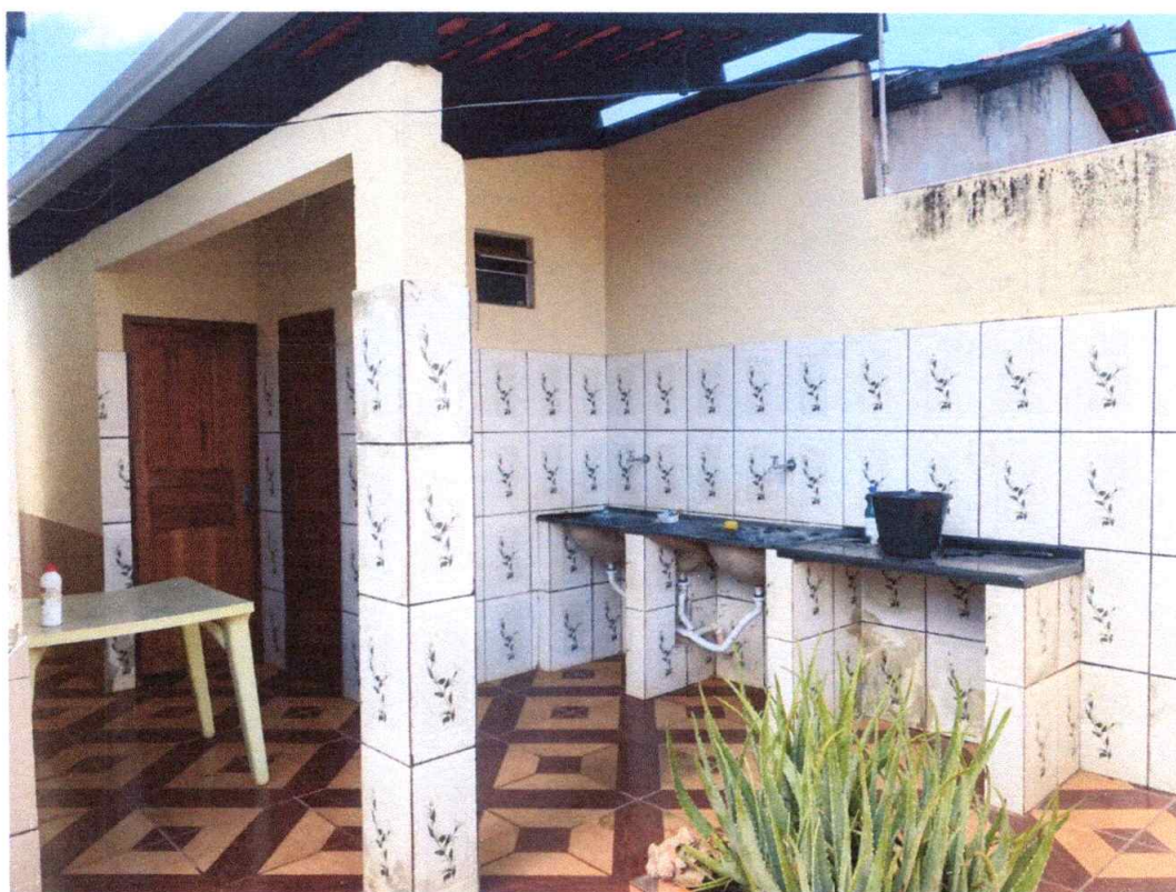
Figura 5 – Imagem da lavanderia externa coberta.
