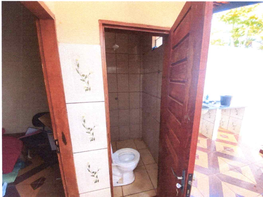
Figura 7 – Imagem do banheiro externo.
