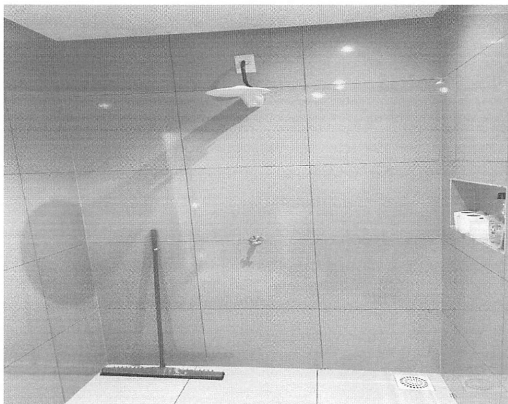
Interior do banheiro.
