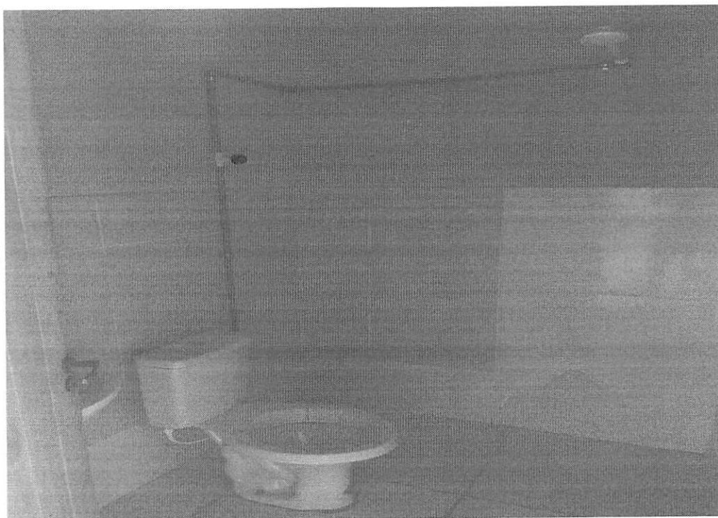
Interior do banheiro.
