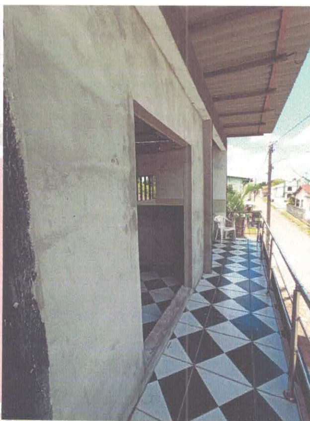
Imagem 24: Sacada (segundo andar)
