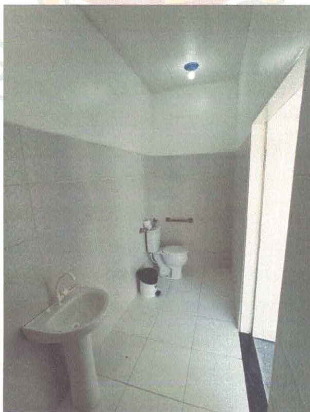
Imagem 18: Banheiro da área externa (banheiro PCD)
