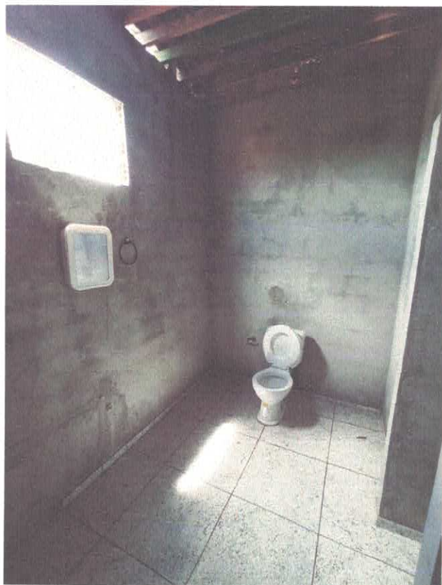
Imagem 23: Banheiro (segundo andar)
