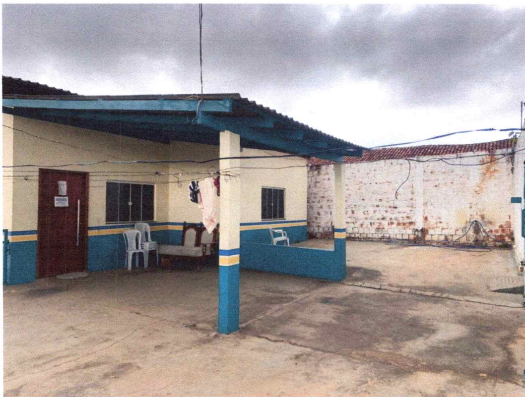
Figura 4 – Imagem da área coberta externa do imóvel.
