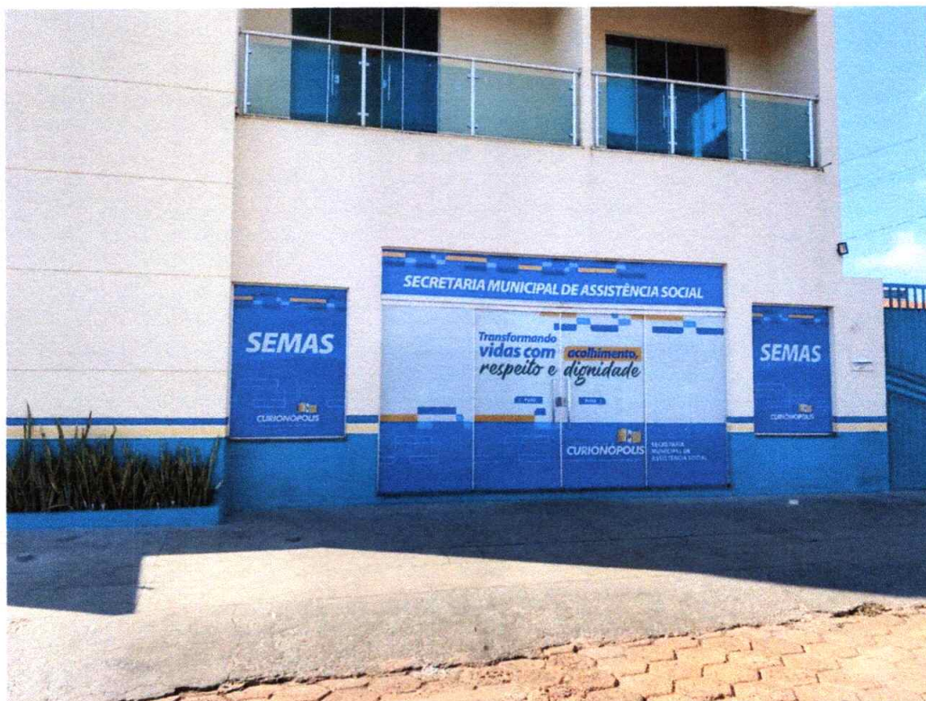
Figura 2 – Imagem frontal do imóvel, comercial.
