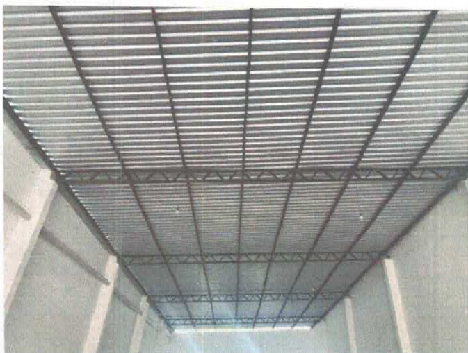
Imagem 04 – Parte interna da cobertura.
